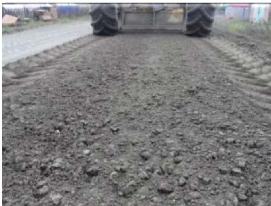
Рис.4– Общий вид дорожного основания после усреднения
