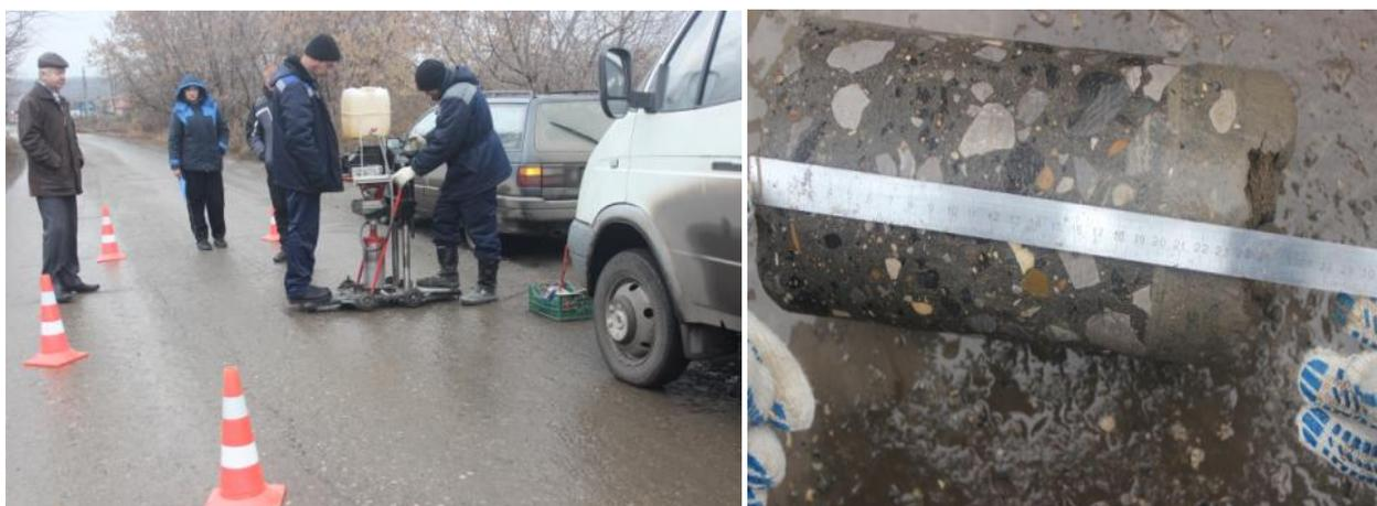
Рис.2– Отбор проб kern отборником с фиксацией слоев дорожной одежды
