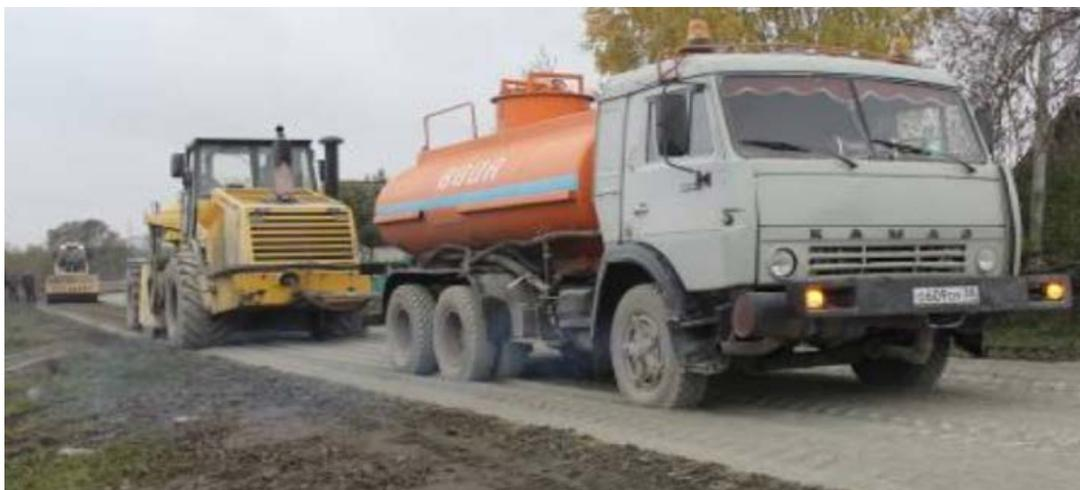
Рис.3– Распределение вяжущего и смешение компонентов с дорожным основанием механизированным способом на месте ведения работ
