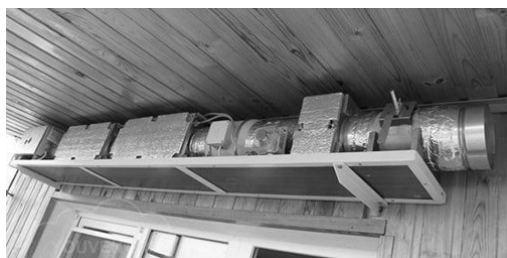
Рисунок 6. Приточная установка вентиляции.
