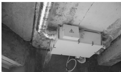
Рисунок 8. Подвесная приточная установка.
