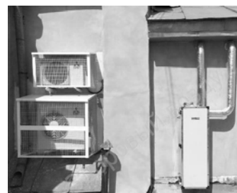
Рисунок 7. Наружная приточная установка.
