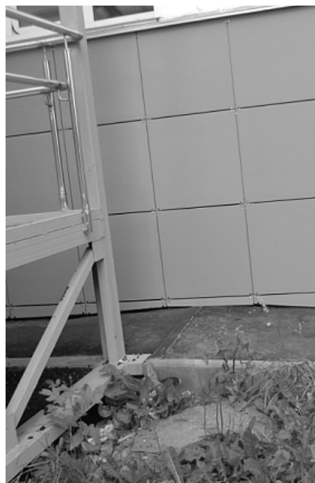
Рис. 2 - Состояние отмостки и цоколя после реконструкции
