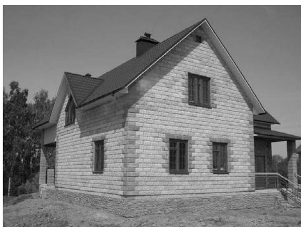
Рис 2. Строительство здания из ячеистого бетона
