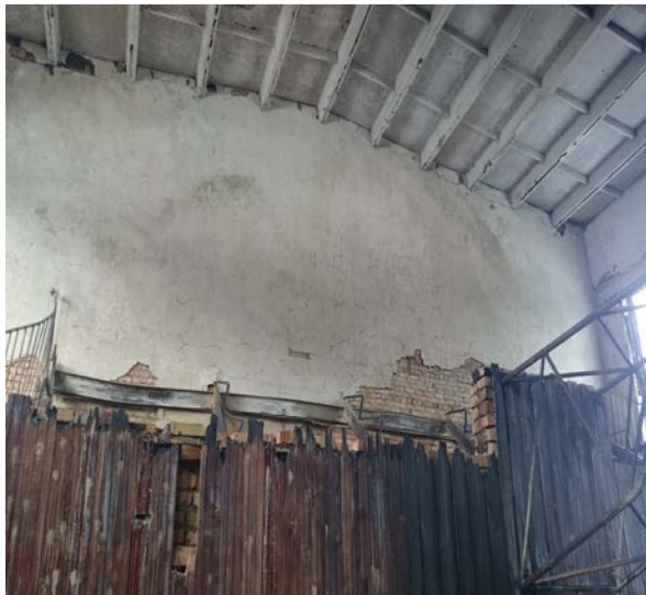
Рис.5. Повреждения части перегородки и штукатурного слоя внутри спорткомплекса
