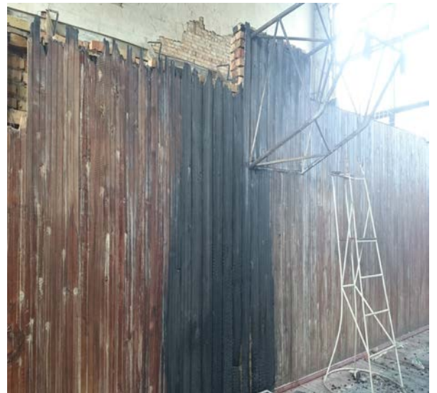
Рис.6. Повреждения части перегородки внутри спорткомплекса
