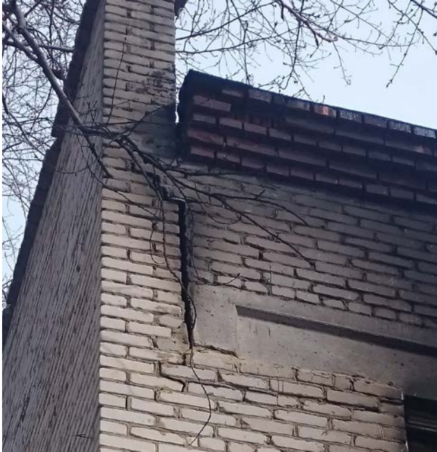
Рис.3 Трещина в кирпичной стене здания
