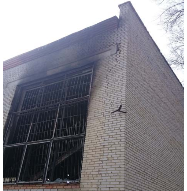
Рис.4 Трещина в кирпичной стене здания и уничтоженные вследствие пожара окна
