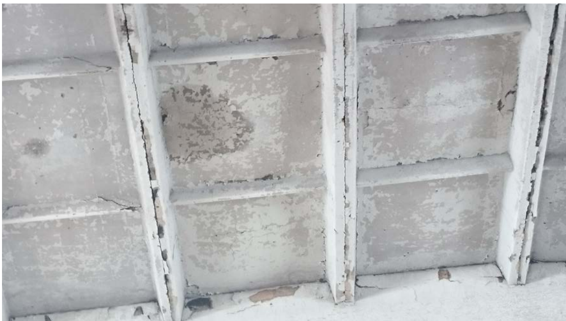
Рис.1 Выпадение швов плит покрытия
