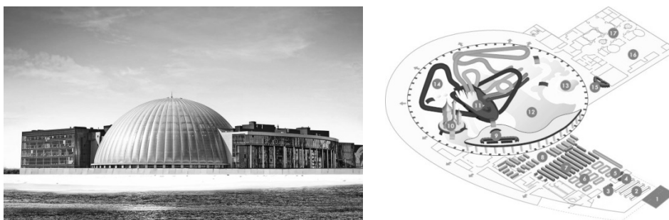
Рис.5, 6 Аквапарк «Питерленд», г.Санкт-Петербург.
