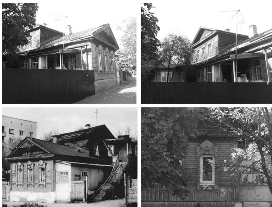
Рис. 4. Ул. Гоголя, 1Б. Фотофиксация по натурным обследованиям автора
